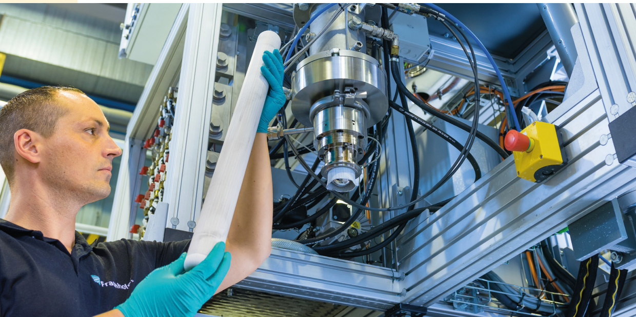
Abbildung 7: Anlagensteuerung eines Extruders zur Herstellung von Batterieelektrolyten. © Fraunhofer IKTS
